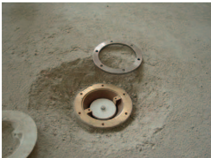
Napouštěcí tryska – provedená se šroubovací přírubou
